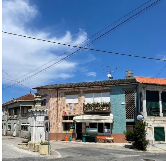
Figura 31. Edifício com piso de comércio
