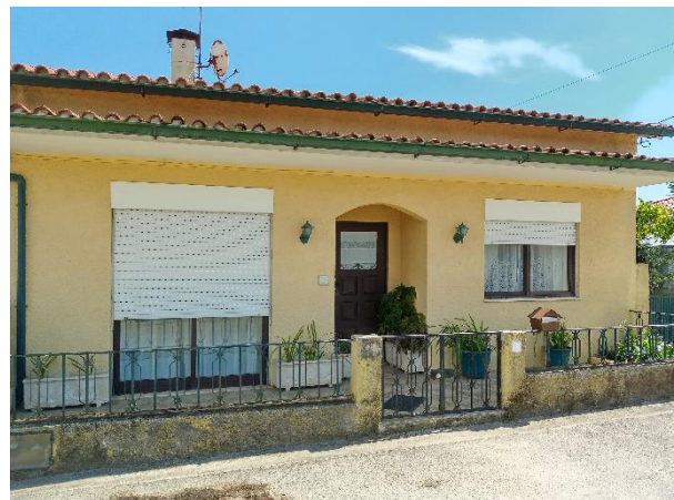
Figura 33. Cobertura com beirado e caleira
