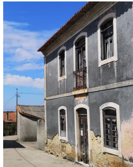
Figura 40. Caixilharias degradadas
