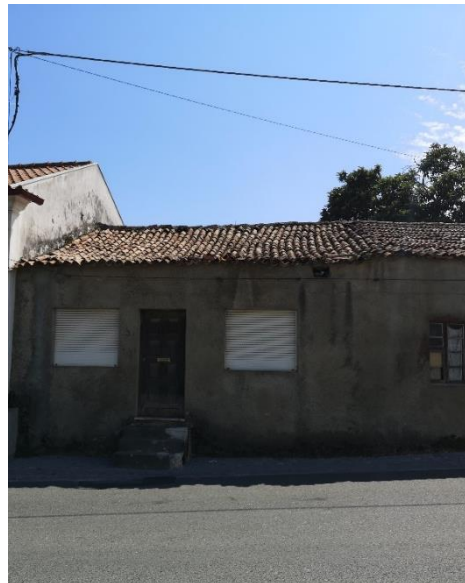
Figura 34. Cobertura deformada
