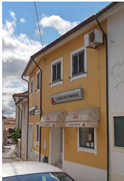
Figura 36. Edifício com um piso de comércio
