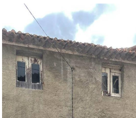
Figura 46. Caixilharias degradadas
