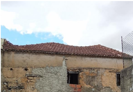
Figura 39. Cobertura deformada
