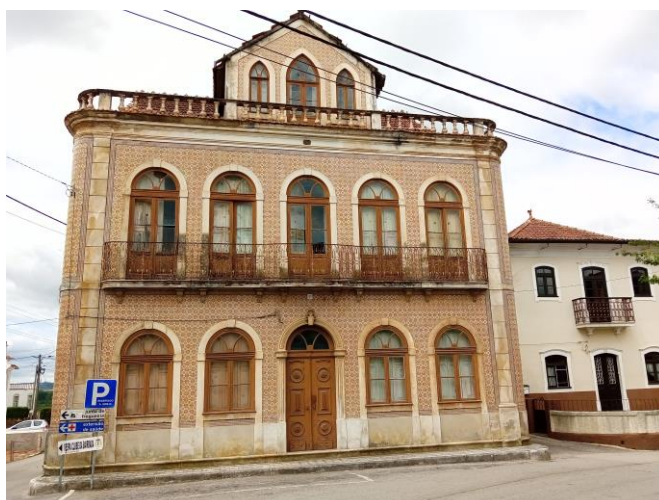
Figura 58. Casa dos Castilhos
