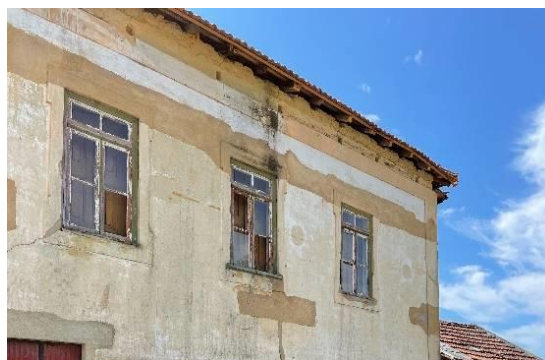
Figura 48. Caixilhariias degradadas
