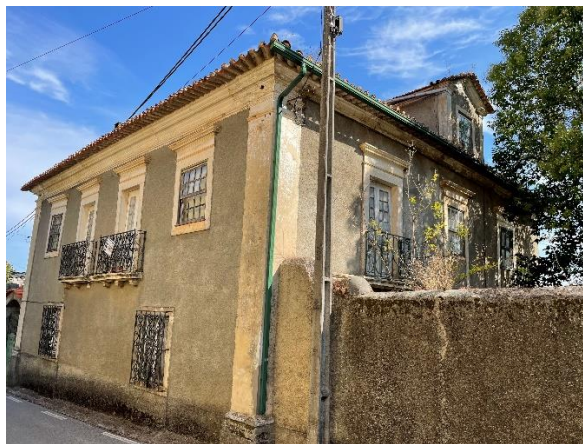
Figura 14. Casa na Rua Visconde Seabra, n.º 2
