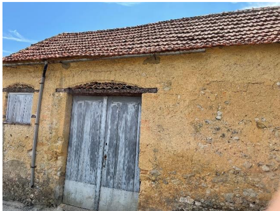
Figura 42. Cobertura deformada
