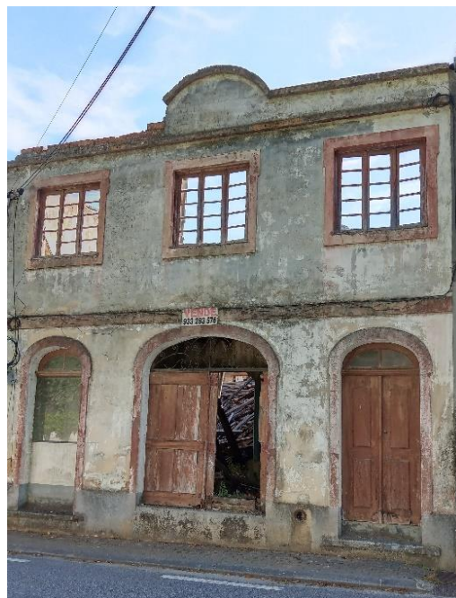
Figura 43. Cobertura colapsada
