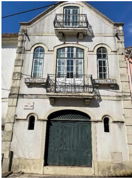
Figura 18 . Edifício relevante na Rua Visconde Seabra
