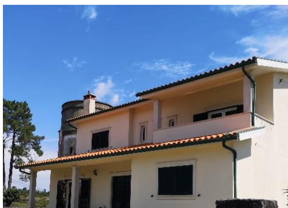
Figura 41. Cobertura com beirado e caleira
