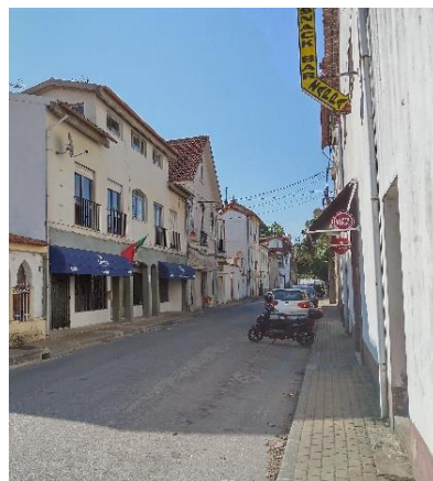
Figura 39. Edifício com piso de comércio
