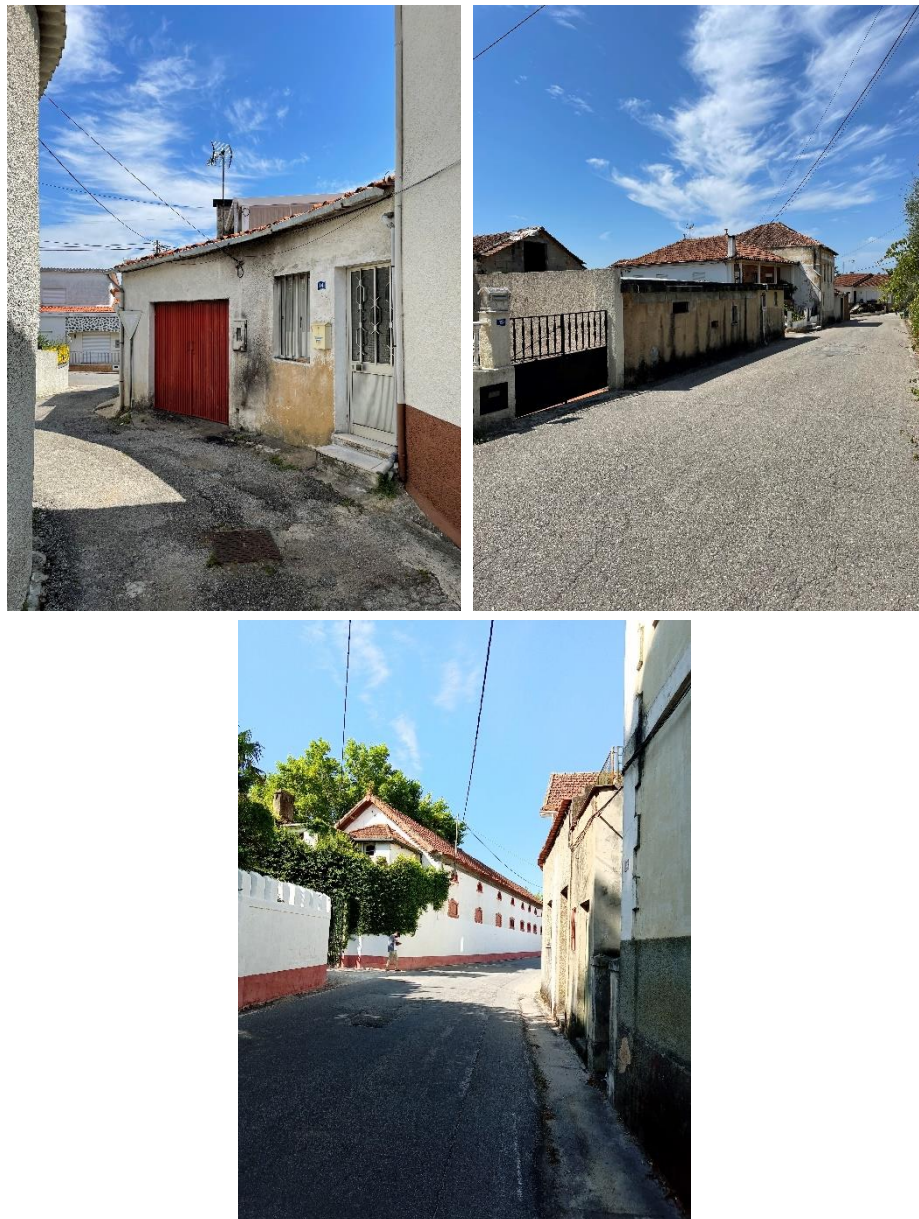
Figura 47. Exemplos da estrutura viária de Mogofores
