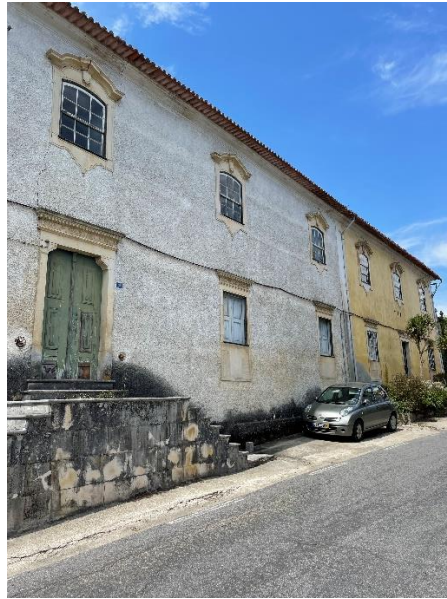
Figura 13. Casa na Rua Visconde Seabra, n.º 1
