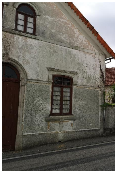
Figura 53. Caixilharias degradadas
