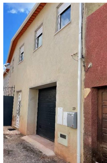
Figura 47. Cobertura com beirado e caleira
