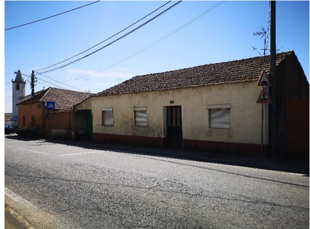
Figura 48. Cobertura deformada
