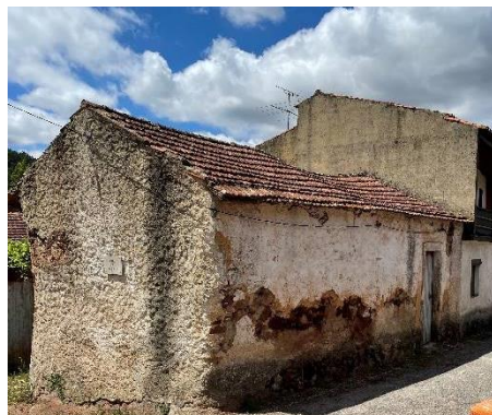
Figura 36. Cobertura deformada
