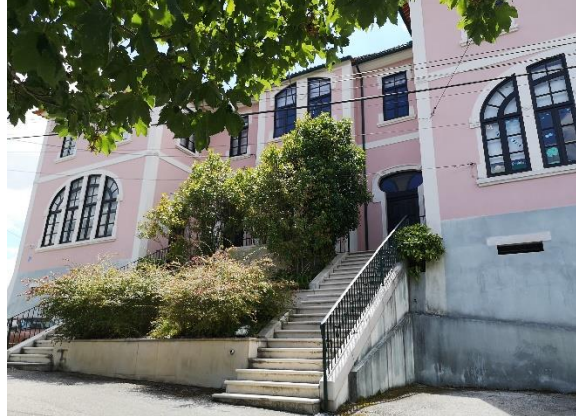
Figura 15. Edifício da Junta de Freguesia
