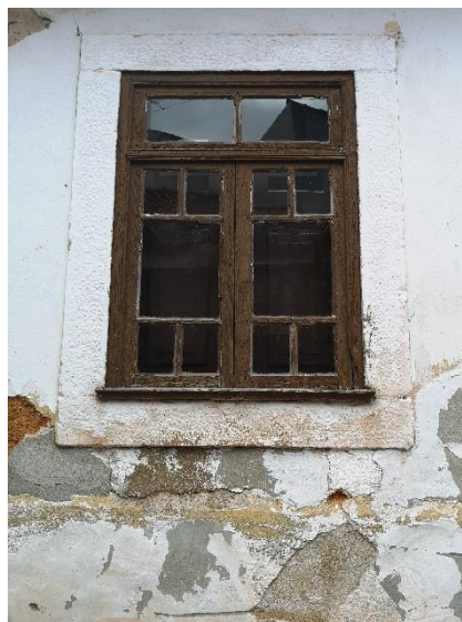
Figura 42. Caixilharia degradada
