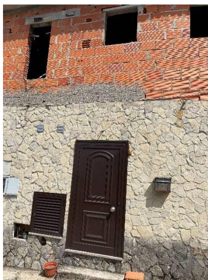
Figura 43. Edifício parcialmente sem caixilharia
