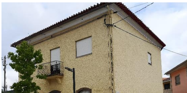
Figura 35. Cobertura com beirado e caleira
